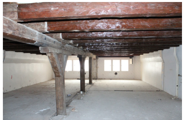
Bestandskonstruktion im Obergeschoss
