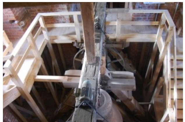
Ebene 3 – Glockenebene mit neuem Umgang
