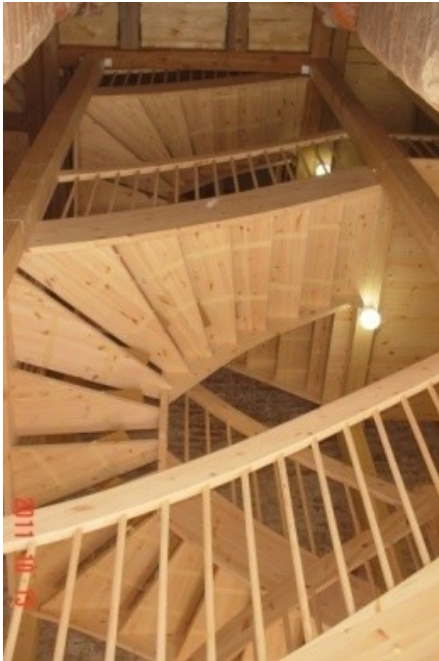
Ebene 1 – Zugang über neue Treppenanlage
