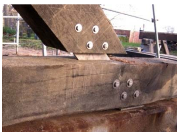
Anschluss Diagonale-Schwelle
